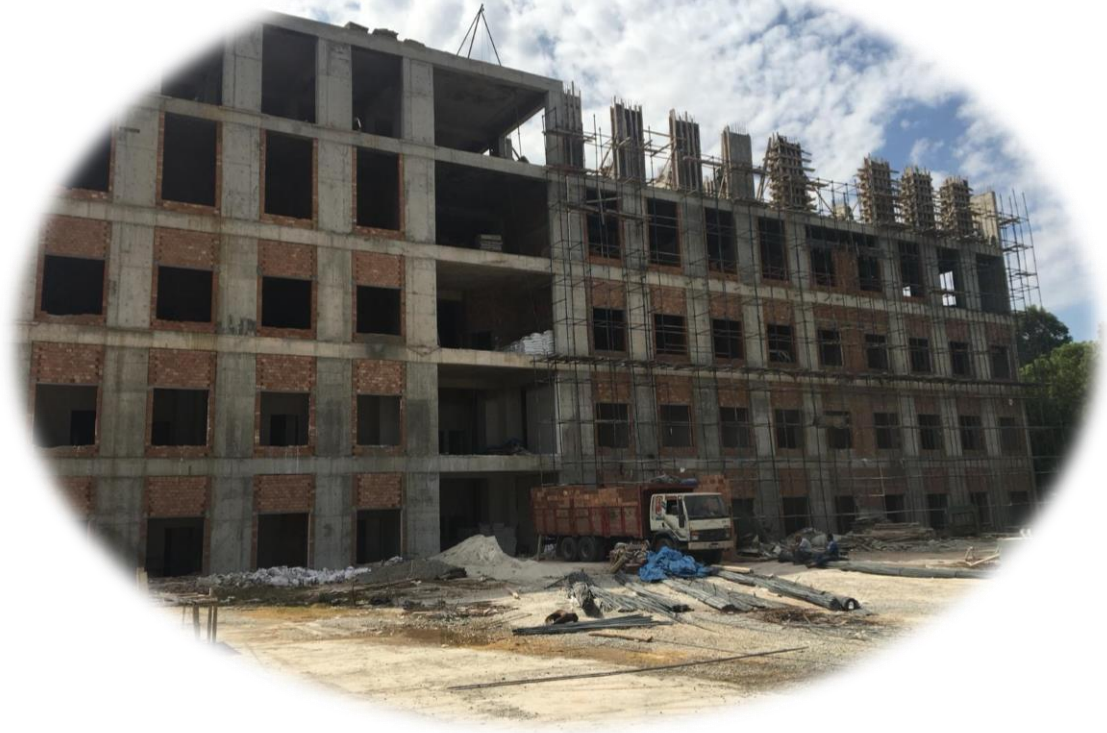
Onkoloji Hastanesi Binası Yapımına Ait Görsel
